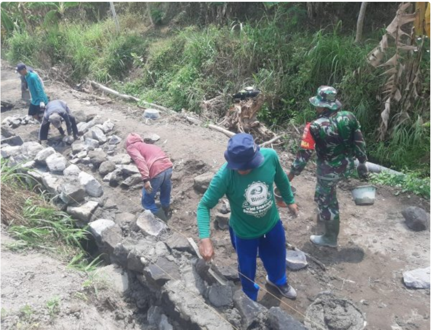
Koramil 09 Prambanan Bangun Talud Di Desa Geneng Klaten Program KBMKB, Ini Kata Danramil Prambanan
