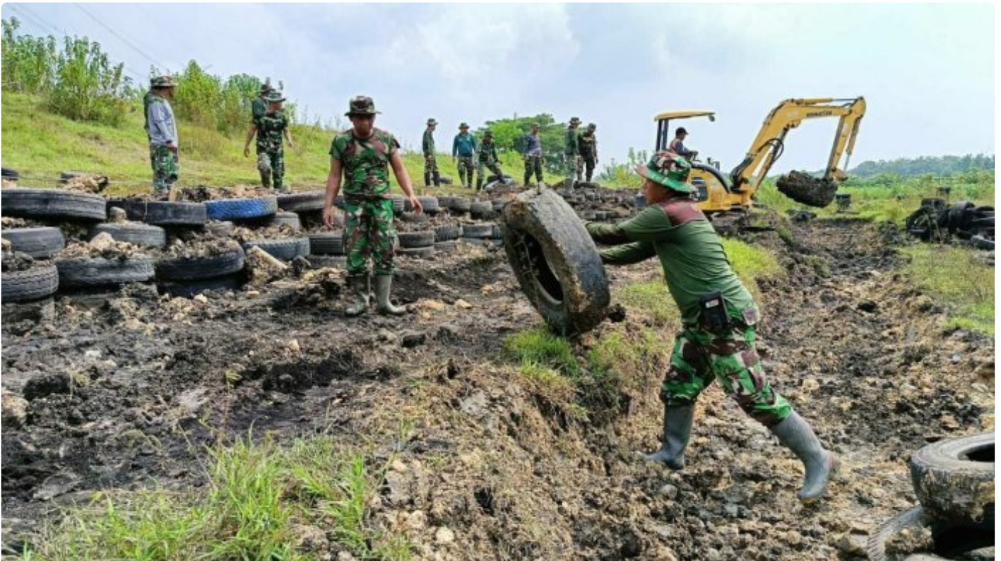
Kodim 0723/Klaten Keraahkan Alat Beratnya Untuk Perbaikan Tanggul Lapangan Tembak
