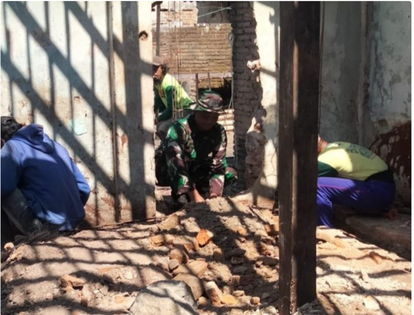
Kepedulian Babinsa Ceper Bantu Renovasi Rumah Warga Binaan
