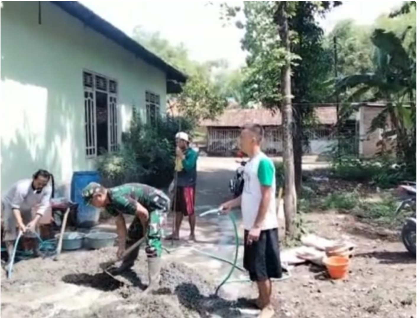
Bantu Kesulitan Warga Babinsa Ceper Cor Lantai Rumah Warga
