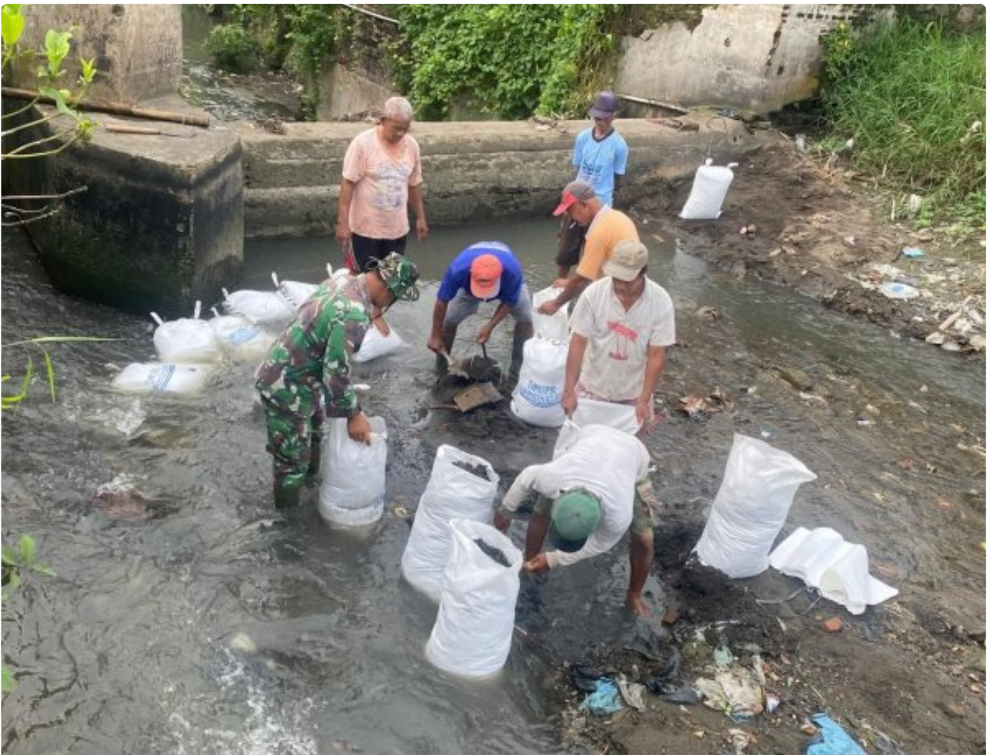
Babinsa Gotong Royong Pembersihan Sampah Dan Perbaikan Tanggul Sungai di Kampung Bendo Buntalan Klaten
